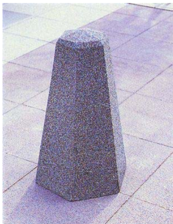
Figure 30 – Exemple de borne devant respecter la hauteur minimale de 50 cm
