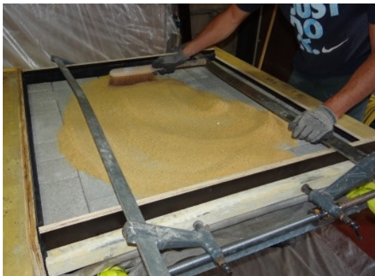
Figure 44 – Mise en place du revêtement - remplissage à la balayette et affermissement à la masse
