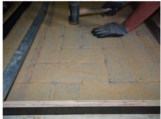
Figure 44 – Mise en place du revêtement - remplissage à la balayette et affermissement à la masse
