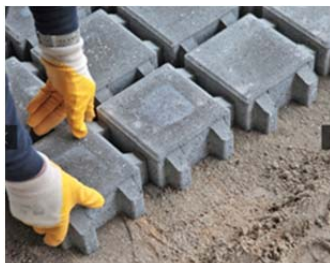
Figure 20 – Exemple de pavés à joints larges avec écarteurs intégrés
