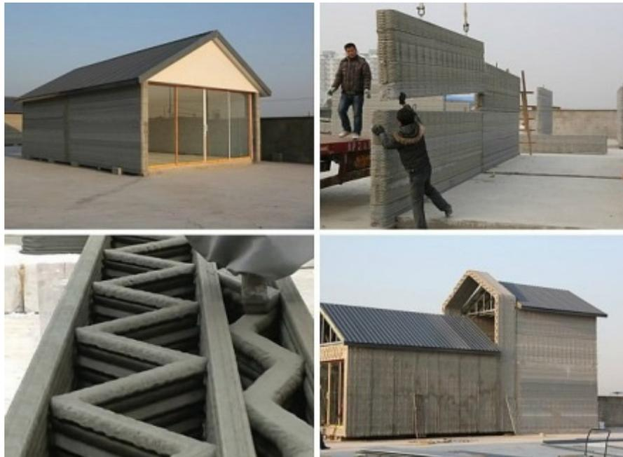
Figure 17 : Réalisation de maison en éléments préfabriqués imprimés en 3D
