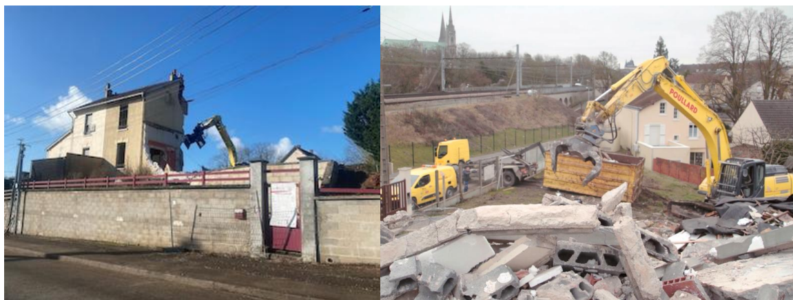
Figure 12 – Illustration de la phase déconstruction
