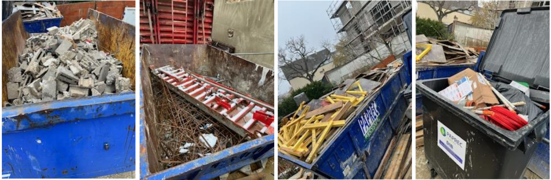
Figure 20 – Tir des déchets sur chantier selon 4 flux : inertes, métaux, bois et DIB
