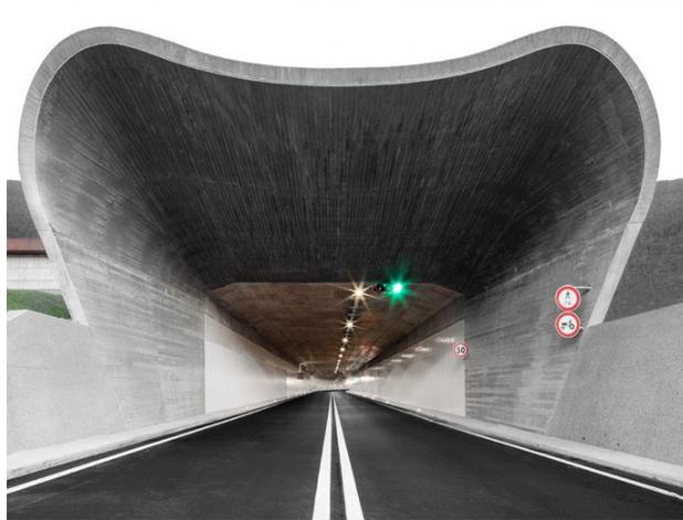
Dans le cadre de travaux sur le périphérique central de jonction Bressanone-Varna dans le nord de l'Italie, un tunnel en béton a été conçu par l'agence d'architectures ModusArchitects. Le béton utilisé pour réaliser les courbes de ce tunnel a été fabriqué à partir de matériaux excavés d'un autre projet d'infrastructure, le tunnel de base du Brenner qui est actuellement en construction entre l'Autriche et l'Italie.
