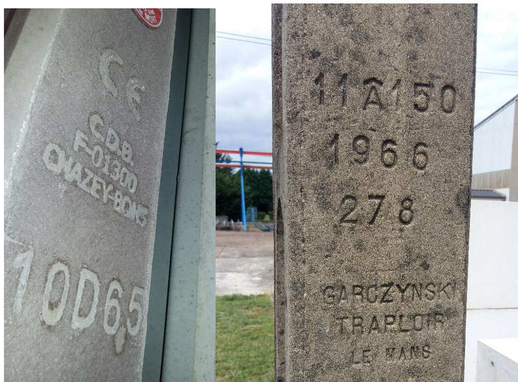
Figure 4 – Inscription des informations de traçabilité gravées sur des poteaux après fabrication
