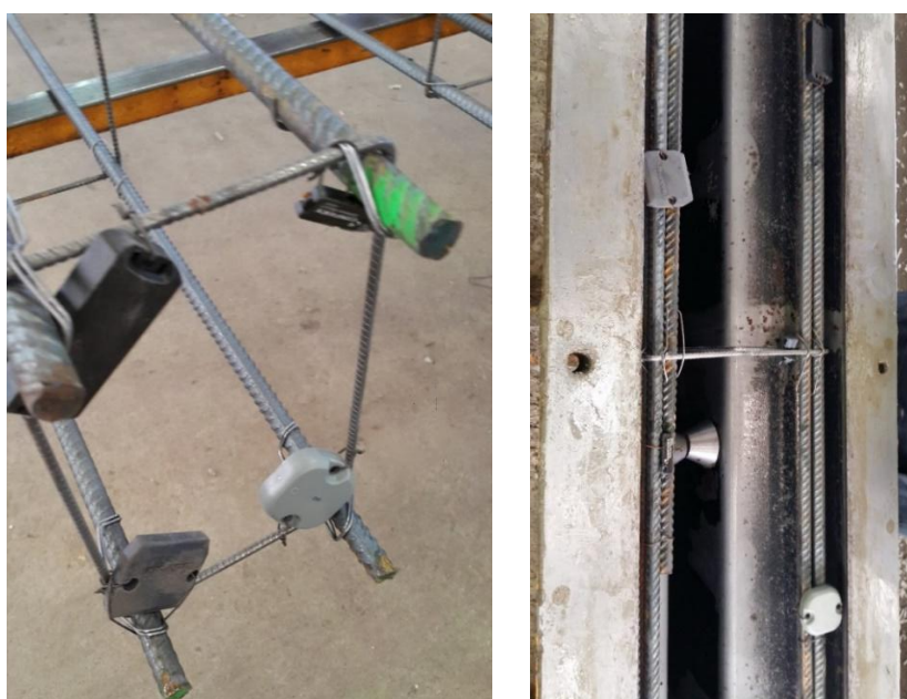
Figure 25 – Installation des étiquettes RFID (à gauche : configuration en tête de poteau ; à droite : configuration pour une lecture par le pont)
