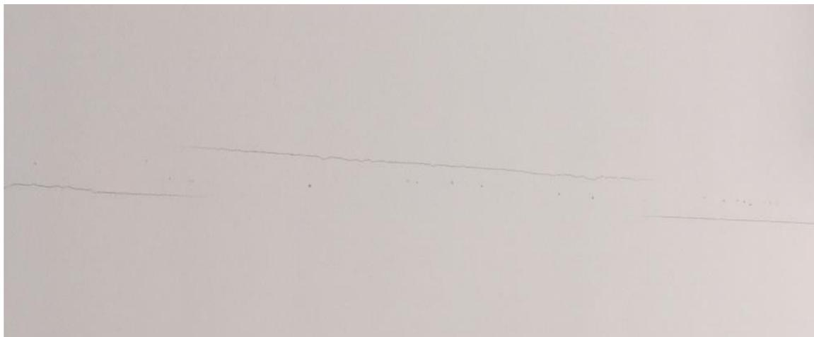
Figure 3 – Fissuration du revêtement
