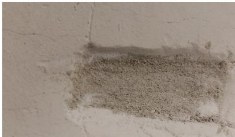
Figure 19 – Fissuration du revêtement sans fissuration du produit de joint
