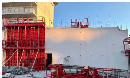
Voile de béton bas carbone sur le chantier de la résidence AL-FA
