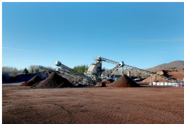
Figure 14 – Carrière de pouzzolane (Dugour Pouzzolane)
