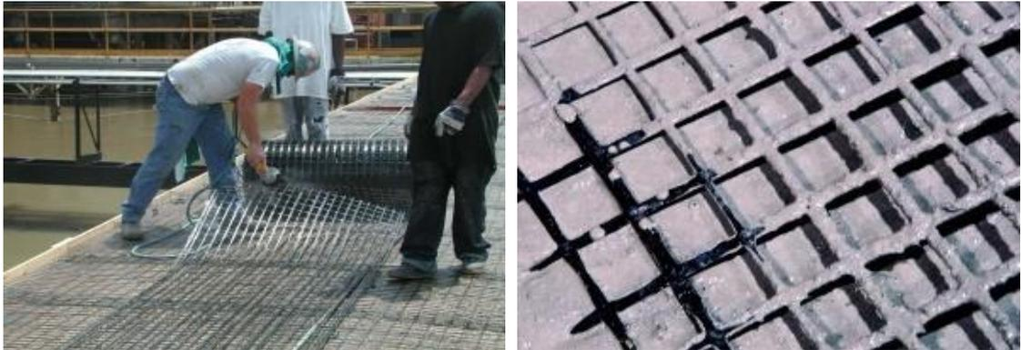
Figure 19 – Mise en œuvre de C-GRID®
