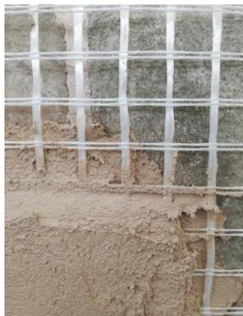
Figure 31 - Treillis en fibres de verre AR - AR GAVAZZI
