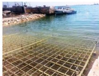
Figure 29 - Treillis en fibre de verre
