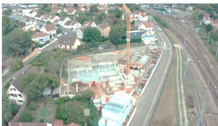
Figure 14 – Illustration de la configuration du chantier
