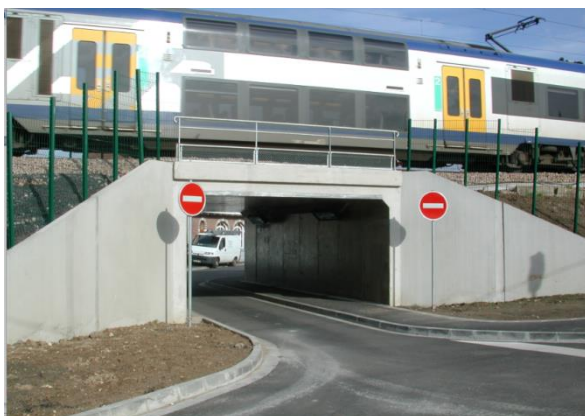
Préfabrication sur mesure Ouvrage
