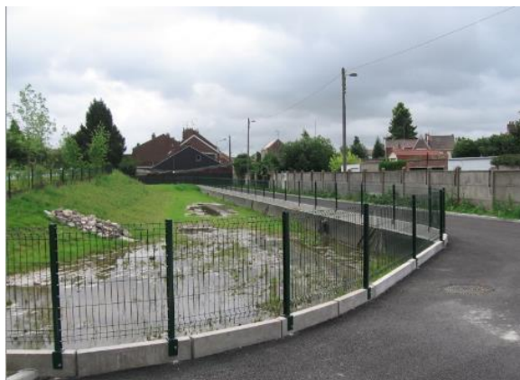
Bassin d'orage au Centre hospitalier de Valenciennes
