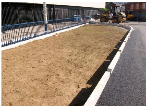
Réservoir d'eau pour l'ANRU à Drancy
