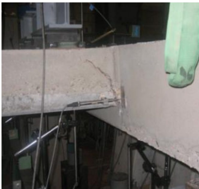
Photo 21 : Vue latérale opposée : fissure inclinée sur l'épaisseur du plancher
