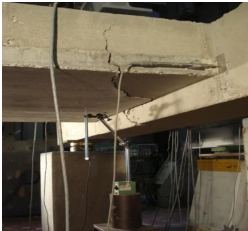
Photo 7 : Mesure en continu de la flèche de la dalle à l'aide d'un capteur de déplacement positionné à mi largeur de la prédalle et dans l'axe du chargement.
