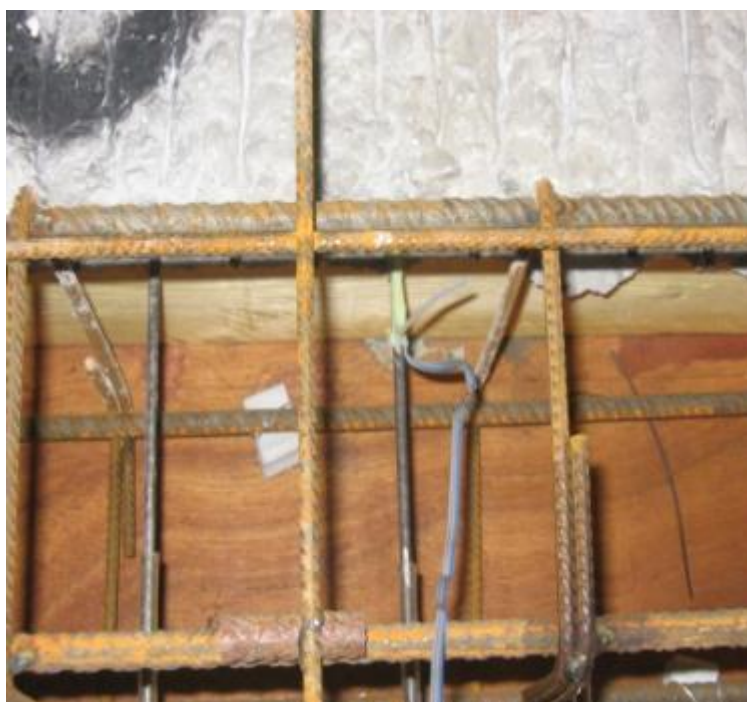
Photo 10 : Vue des armatures de précontrainte à la traversée de la poutre d'about (avant coulage). Mesure en continu des déformations de deux armatures à proximité de l'about de la prédalle (jauges de déformation collées latéralement sur la partie non gainée de deux armatures en extrémité de chaque prédalle).
