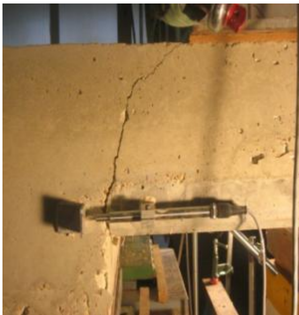
Photo 11 : Vue latérale : fissure inclinée sur l'épaisseur du plancher
