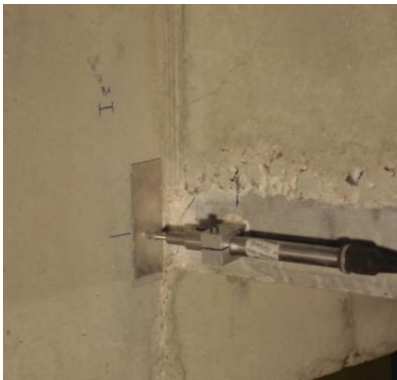
Photo 8 : Mesure de l'ouverture de fissure entre la prédalle et l'appui par deux capteurs de déplacements horizontaux sur la tranche de l'élément (1 capteur de chaque côté de la prédalle).
