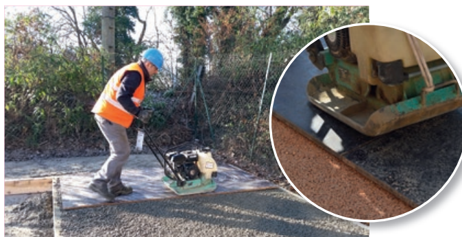
Photo 53 - Compactage au patin vibrant.
