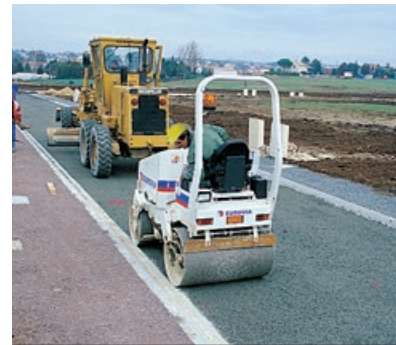
Photo 56 - Atelier de mise en œuvre du béton drainant.
