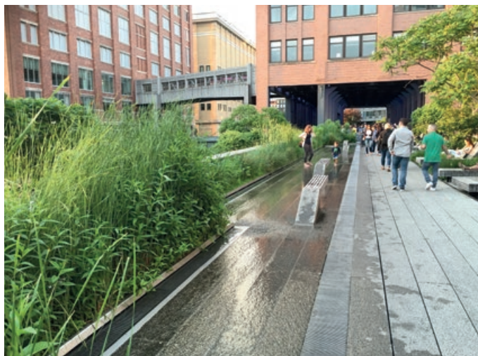
Photo 15 - Passage en produits préfabriqués avec brumisateurs.
