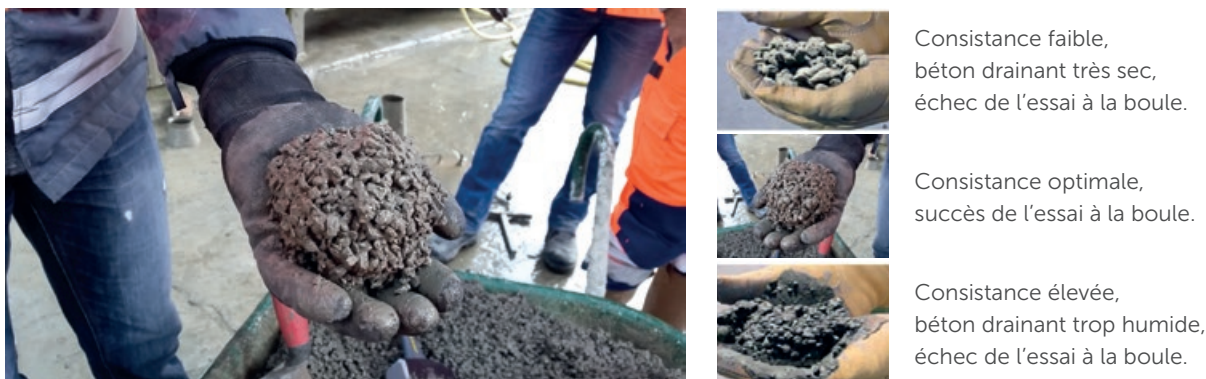
Photo 45 - Consistance du béton drainant : test à la boule.
