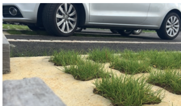
Photo 74 - Engazonnement des alvéoles (système ViaVerde®).
