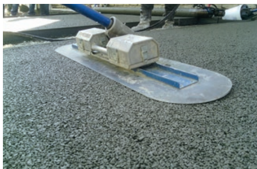
Photo 51 - Passage de la lisseuse vibrante.
