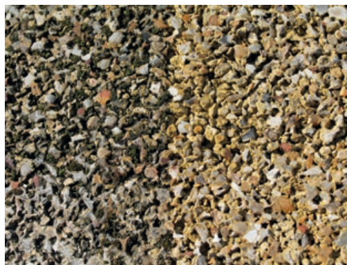
Photo 98 - Aspect du béton drainant avant nettoyage (partie gauche) et après nettoyage (partie droite).
