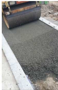
Photo 55 - Compactage du béton drainant.
