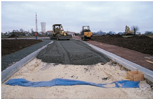
Photo 54 - Répandage du béton drainant à la niveleuse.
