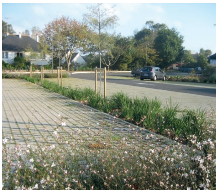
Photos 31 - Aménagement urbain en pavés à joints larges engazonnés, couplé avec une noue paysagère.
