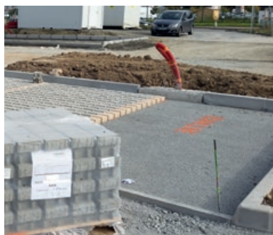
Photo 79 - Lit de pose en gravillons.
