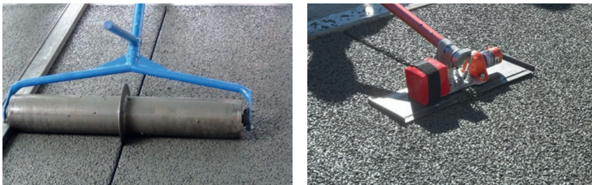
Photos 59 et 60 - Exécution des joints dans le matériau frais à l'aide d'un rouleau jointeur (à gauche) ou d'une jointeuse vibrante (à droite).
