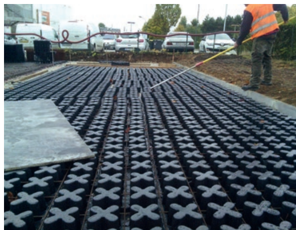
Photo 65 - Réalignement des moules (système Grasscrete®).
