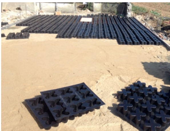
Photo 64 - Pose des moules (système Grasscrete®).
