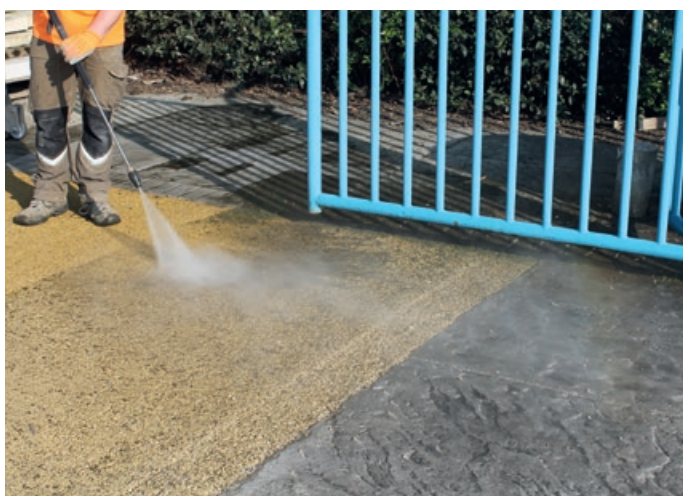
Photo 93 - Lavage au nettoyeur haute pression.
