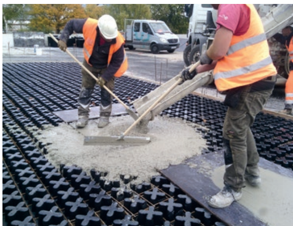
Photo 67 - Coulage du béton sur les moules Grasscrete®
