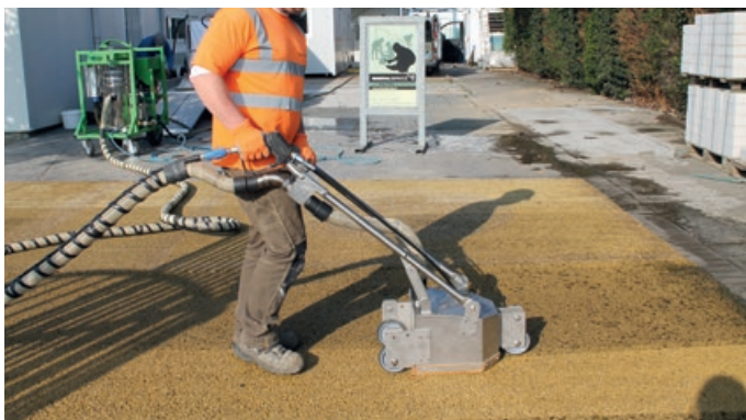
Photo 97 - Décolmatage d'un revêtement en béton drainant à l'aide d'un nettoyeur Moby Cline®.
