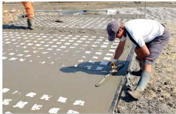
Photo 70 - Talochage du béton (système ViaVerde®)
