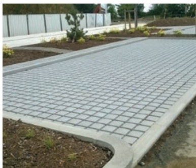
Photo 81 - Réalisation en pavés à joints larges avant garnissage des joints.
