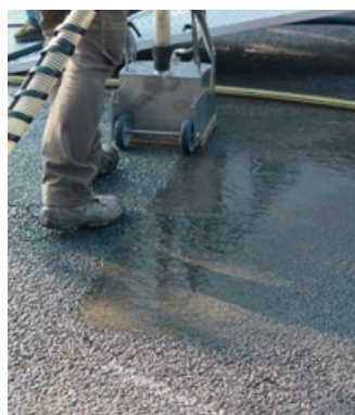
Photo 100 - Le nettoyeur aspire la boue produite.
