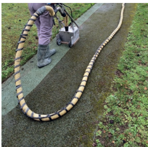
Photo 94 - Nettoyage par pression d'eau suivi d'aspiration.
