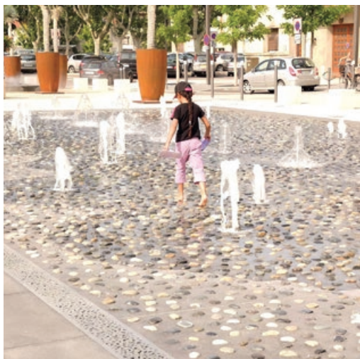
Photo 14 - Place en béton coulé en place avec jets d'eau.
