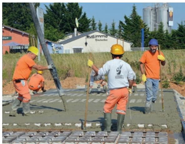
Photo 68 - Coulage du béton sur les moules ViaVerde®
