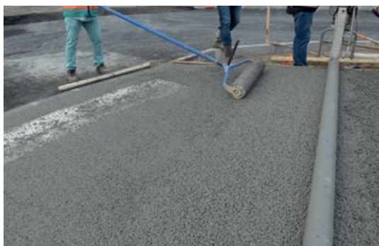
Photo 50 - Compactage au rouleau lesté.
