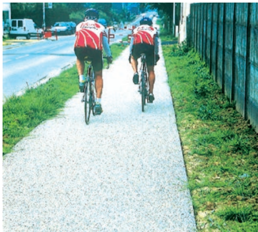
Photo 43 - Une piste cyclable en béton drainant associée à une tranchée drainante en grave naturelle assurant les fonctions hydrauliques
