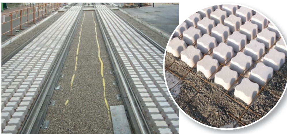
Photo 66 - Pose des moules et des armatures (système Via Verde®).
