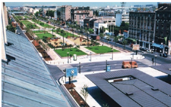
Photo 4 - Autoroute A1 après requalification : couverture et aménagement paysager : jardins Wilson.
