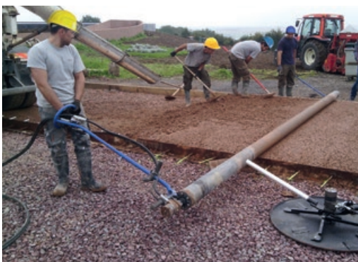
Photo 46 - Coulage du béton et réglage au « roller-striker ».
