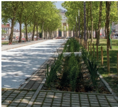
Photo 44 - Revêtement drainant en pavés à joints larges couplé à un réseau de noues.
