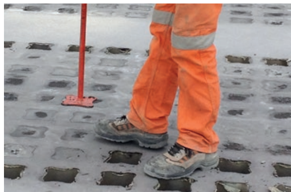
Photo 72 - Désoperculage du système ViaVerde®.
