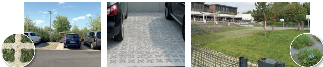
Photos 22 à 24 - Exemples diversifiés d'emploi de solutions de revêtements avec système constructif à ouvertures de drainage.
