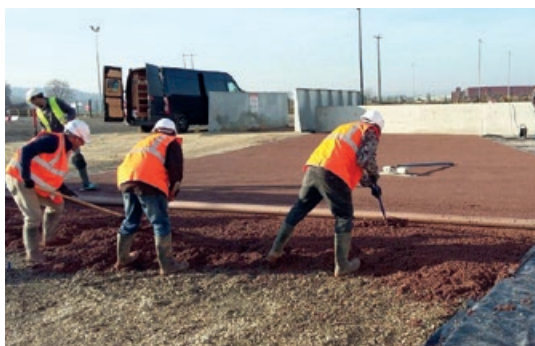
Photo 52 - Nivellement au roller-striker.
