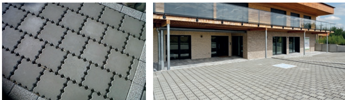
Photos 32 et 33 - Exemples de pavés perforés.
