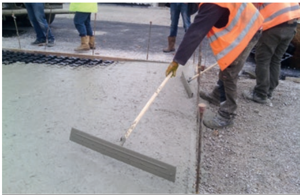
Photo 69 - Répandage à la raclette (système Grasscrete®)
