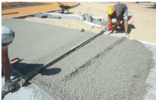
Photo 48 - Nivellement à la règle manuelle.
