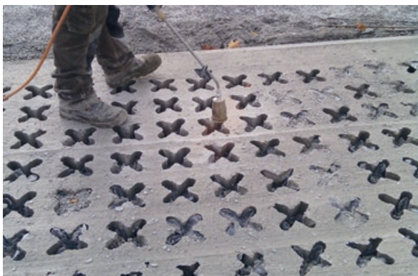
Photo 71 - Utilisation d'un chalumeau à gaz pour faire fondre le moule en plastique (système Grasscrete®).
