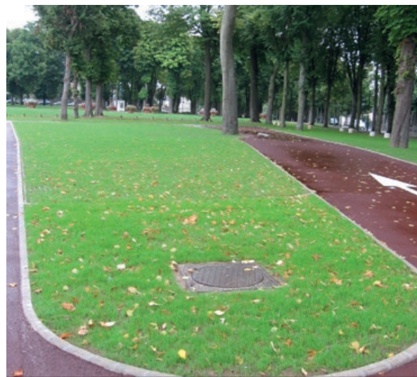
Photo 87 - Revêtement en dalles drainantes engazonnées.
