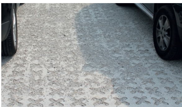
Photo 73 - remplissage des alvéoles avec des gravillons (système Grasscrete®).
