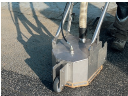
Photo 99 - Le nettoyeur injecte de l'eau sous pression.
