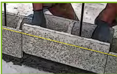
**3** Positionnez les blocs sur le mortier de l'arase en maintenant les armatures verticales en position.
