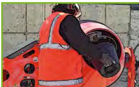
**4** Préparez le mortier, n'oubliez pas d'ajouter un adjuvant hydrofuge, en l'absence de bande bitumineuse, pour éviter les remontées d'humidité par capillarité.
