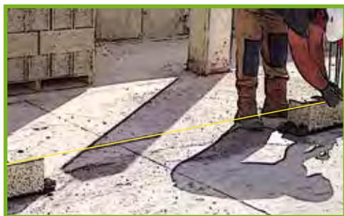
**14** Après la pose des deux blocs d'angle et pour chaînage intermédiaire, tendez votre cordeau sur la face extérieure du mur.
