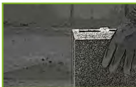
**19** Au besoin, utilisez un bloc accessoire pour coupe ou effectuez une coupe sur un bloc entier pour finir votre rang ou prendre en compte la présence d'un chaînage intermédiaire (voir § Coupe de blocs).
