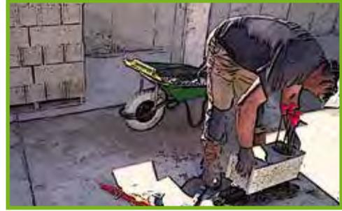
**8** Commencez par poser un bloc d'angle, face pleine en l'enfilant sur les armatures en attentes sur le dessus et en vous aidant de la massette.
