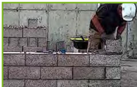
**2** Mettez en place votre bloc d'angle en le réglant bien correctement sur le mortier.
