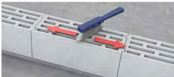
**2) Nettoyez la surface des blocs pour qu'elle soit propre, saine et dépoussiérée sinon le collage des blocs ne pourra être effectif**
