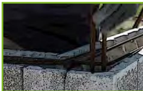
**12** Positionnez les armatures de chaînage vertical en respectant un enrobage minimal de 10 mm avec la paroi intérieure des blocs.
