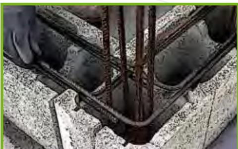
**5** Positionnez les équerres de ferrillage pour assurer la continuité des armatures dans les angles.
