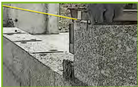
**6** Tendez votre cordeau sur les deux blocs sur le côté extérieur du mur.
