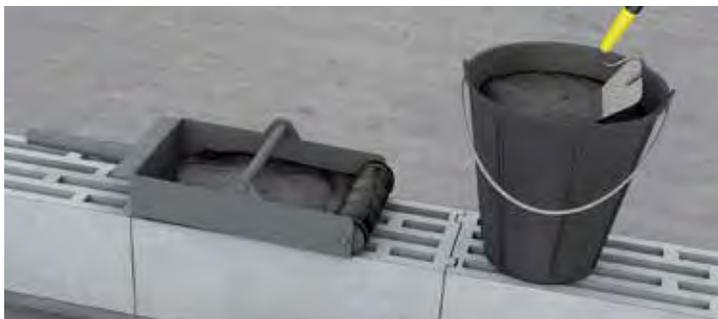
4) Mettez le mortier-colle dans le rouleau applicateur à l'aide d'une truelle
