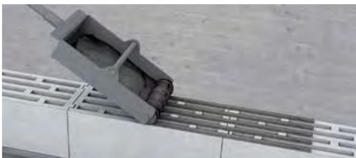
6) Déroulez par longueur de 3 mètres maximum en une seule passe (sans aller-retour). Pour cela, veillez à l'écoulement correct du mortier-colle et si besoin, réglez les écrous papillons
