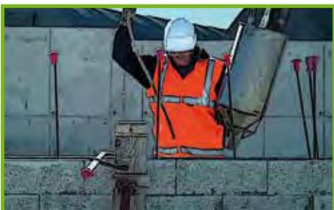
**13** Pour réaliser un coulage proprement, utilisez une manchette pour faciliter la mise en œuvre du béton conforme aux spécifications.
