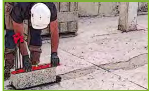
**13** Une fois l'altimétrie contrôlée entre les deux blocs, vérifiez l'aplomb et le niveau de votre deuxième bloc. Recontrôlez l'altimétrie au besoin.
