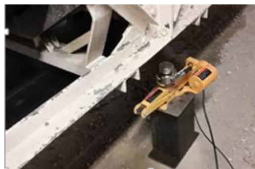
Étape 2 - Mise en place des vérins LEVIATYS® sous les profilés de la bascule
