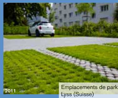
Emplacements de parking Saint-Grégoire (35) Pavés à joints larges engazonnés
