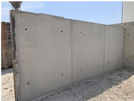
**Figure 11.** Illustration d'un voile coulé avec un béton de GBRC
