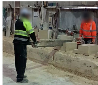
Usage de la tronçonneuse 2 opérateurs
