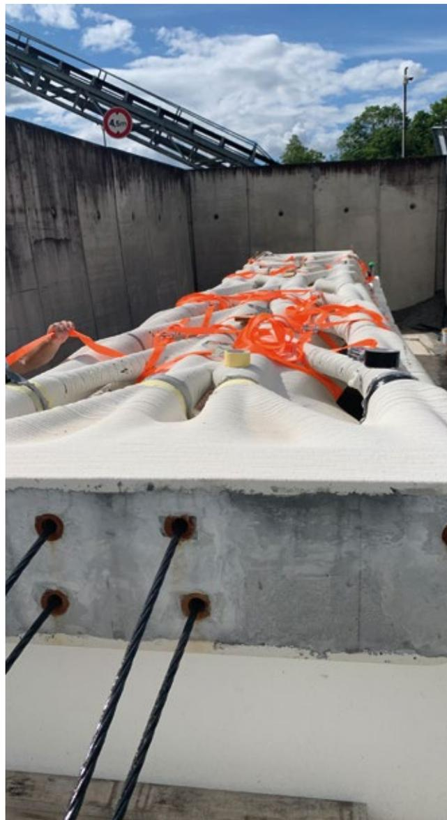
La précontrainte est une méthode qui consiste à appliquer des charges de compression très élevées aux segments d'extrémité afin de comprimer la structure. C'est pourquoi les extrémités ont également été remplies d'un mortier de scellement haute performance, le SikaGrout®-238 chargé, et renforcées par une armature en acier conventionnelle afin d'éviter que cette partie de la structure ne se brise.
