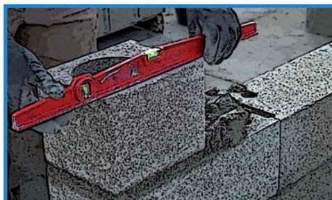
**5** Faites de même au niveau du prochain poteau raidisseur, poser un bloc d'angle face pleine sur le dessus en l'enfilant sur les armatures en attente et en vous aidant de la massette.
