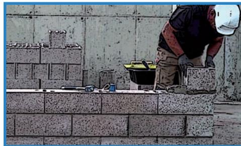
**2** Mettez en place votre bloc d'angle en le réglant bien correctement sur le mortier.
