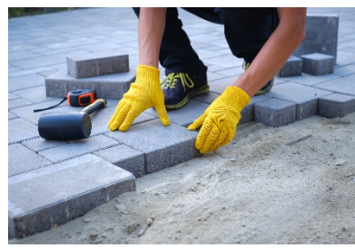
Pose de pavés en béton préfabriqué
