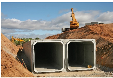
Cadres préfabriqués en béton à section variable
